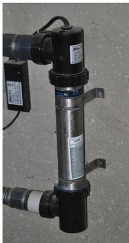
Ontsmetting met een UV-lamp gebeurt in een buisreactor met in het midden een kwikdamplamp beschermd door een kwartsbuis. Het water stroomt tussen de kwartsbuis en de buitenwand van de reactor.
